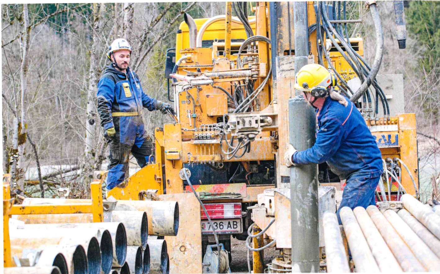
Insgesamt 21 Bohrpunkte umfasst das Untersuchungsprogramm. Die Bohrtiefe beträgt zwischen 30 und 170 m.
